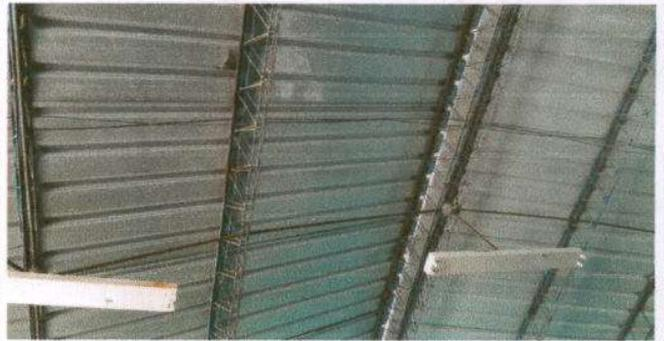
Foto 2: Sustitución de capote y elementos de fijación. (Aula 1)
