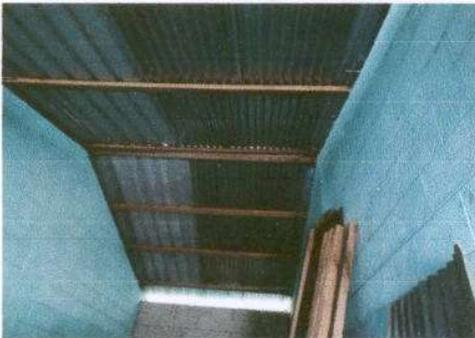
Foto 3: Sustitución de estructura de soporte de manera por metal (Bodega)
