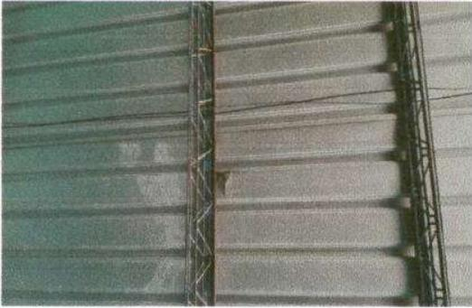
Foto 1: Sustitución de lamina troquelada aluzinc Calibre 26. (Aula 2)
